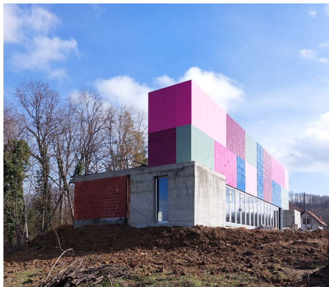
Projekt in Gradačac, Bosnien und Herzegovina Foto vom Baufortschritt, Stand Februar 2022
