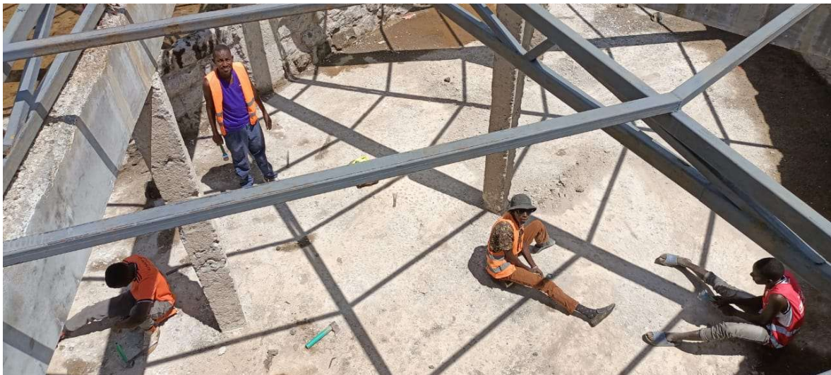
Vorbereitung der Tankbodenoberfläche des gemauerten Tanks mit lokalen Bauarbeitern
