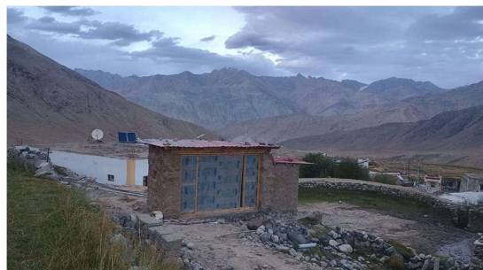
Das Passiv-Solar-Haus im Endzustand.
