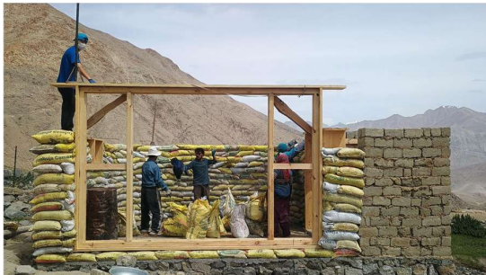
Schnelle Errichtung der Wände mit „earthbag“-Technik für einen passiv solar beheizten Wasserspeicher.
