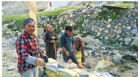
Die lokale Bevölkerung lernt, die „earthbags“ zu verlegen, um die Mauer zu bauen.
