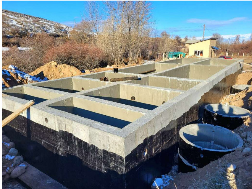
Stand der Bauarbeiten im November 2024
