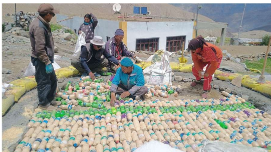
Isolierende Flaschenziegel auf den Boden.
