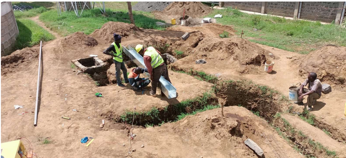
Wasserversorgungsprojekt für die Schule in Suswa, Kenia
